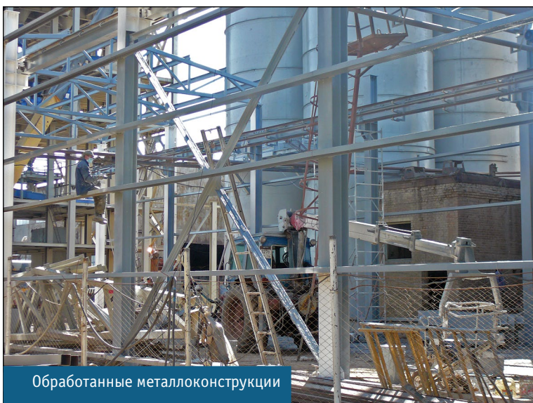
Пропитчик Сафин И.Ф. Нанесение огнезащитного состава на металлоконструкции
